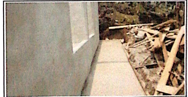
FOTO 6: SUSTITUCION RAMPAS Y VENTANAS.
