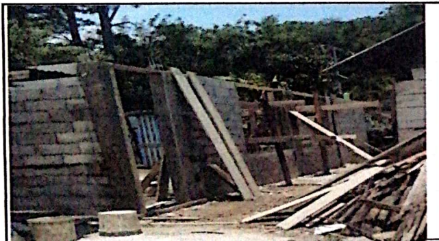
FOTO 3: SUSTITUCION DE COLUMNAS DE CONCRETOS.
